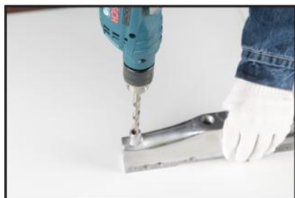
1. Przewierć uszkodzony gwint wiertłem o odpowiednim rozmiarze.
